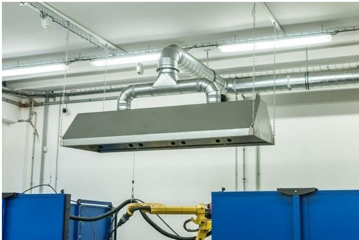
Obr. 3, příklad odsávání stacionárního zdroje, manipulace s uhlím
