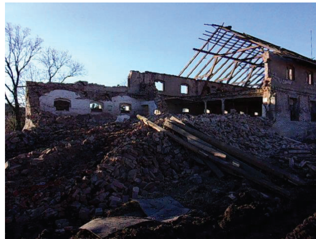
4. Fáze – Strojní demolice – průběžné třídění materiálů a odpadů
