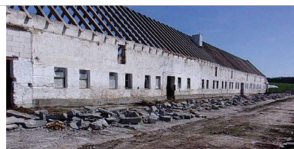
Dekonstrukce budov a navrácení materiálů do výroby
