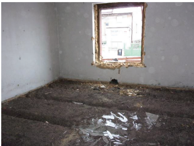
Odstrojený a vyklizený objekt – připraveno na strojní demolici
